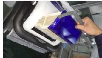
2. Nosta suodatinkotelo pois
