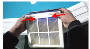
3. Tryck mot mitten för att öppna filterfacket
